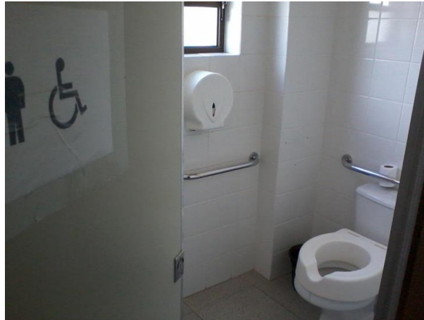
Figura 3 – Banheiro adaptado para deficiente físico.
