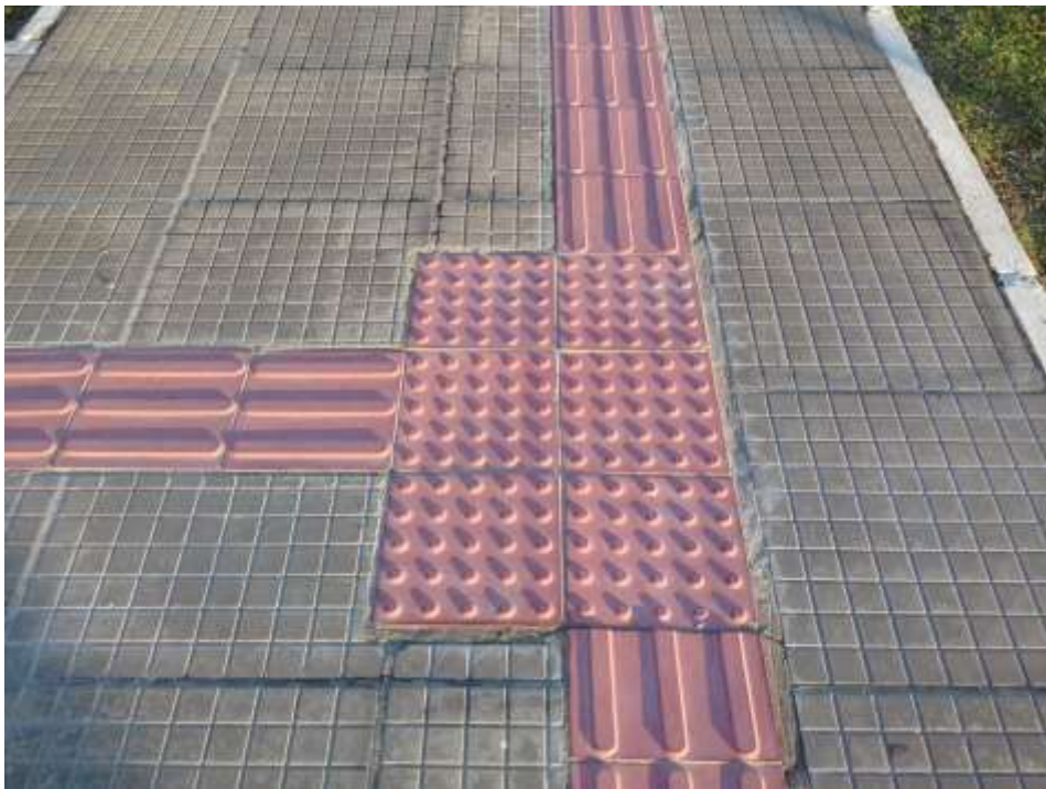
Figura 4 – Piso com sinalização tátil.
