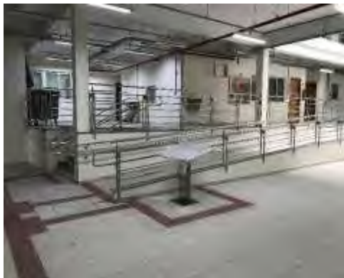
Escada e rampa com guarda-corpo e corrimão.
