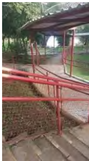
escadas e rampas com guarda-corpo, corrimão e sinalização tátil no piso
