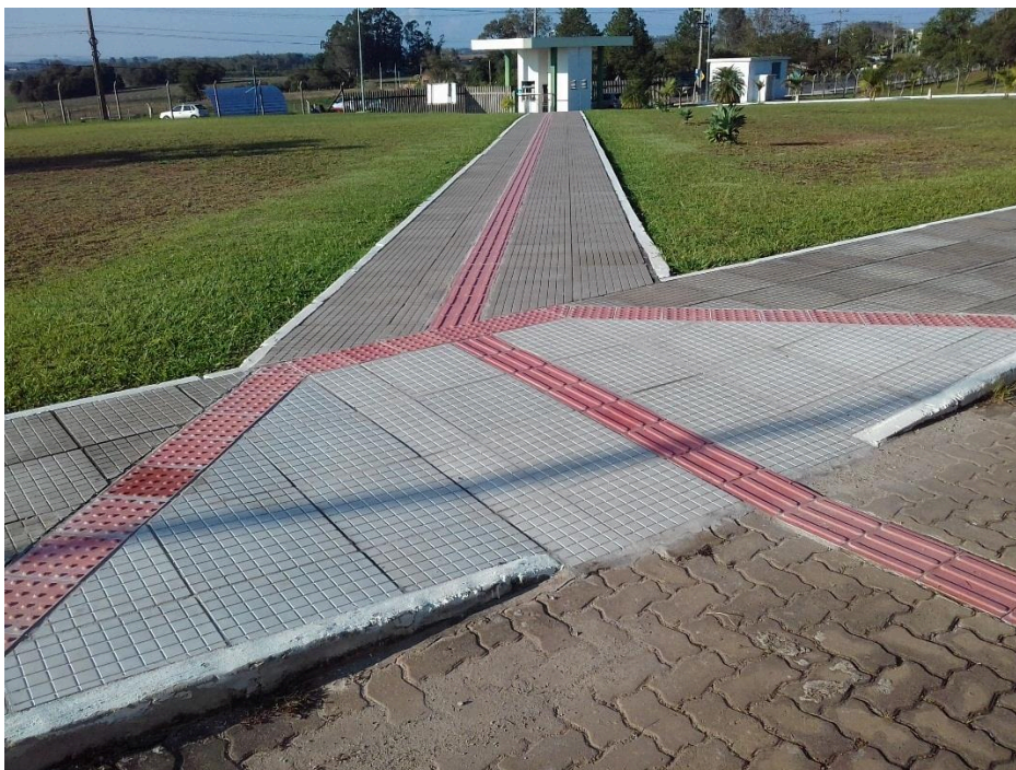
Figura 2 – Rampa para acesso a cadeirantes.
