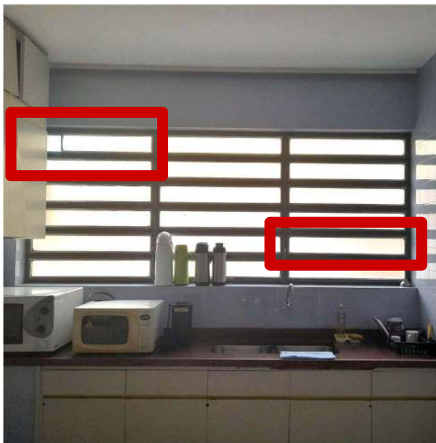
Figura 13: Localização dos vidros de janelas basculantes a substituir. À esquerda: J-06 (térreo - cozinha). À direita: J-10 (2º andar- sanitário).
