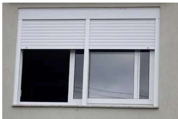
Figura 05: Localização das janelas frente e fundos do 2º andar que receberão novas persianas PVC e grades pantográficas e porta-janela do térreo nos fundos do pavimento que receberá persiana em PVC com caixa externa.
